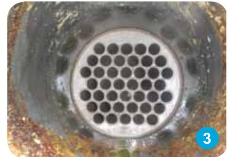
Die abgasseitige Reinigung von Abgaswärmetauschern bei Blockheizkraftwerken ist ein wesentlicher Beitrag um die Effizienz des BHKW Motors zu erhalten.
